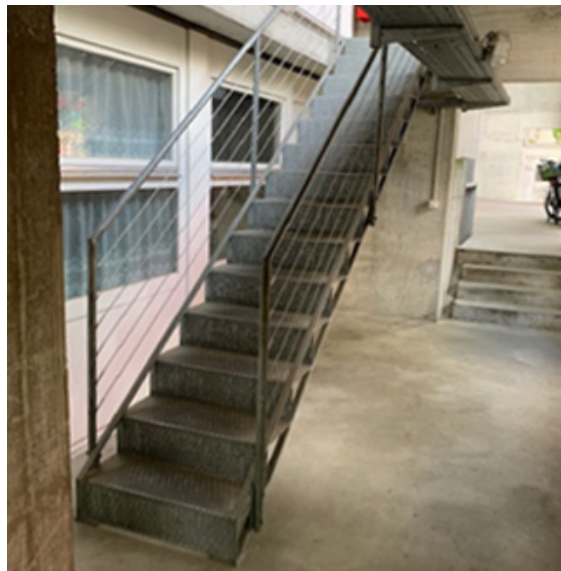
Die Treppe hoch
